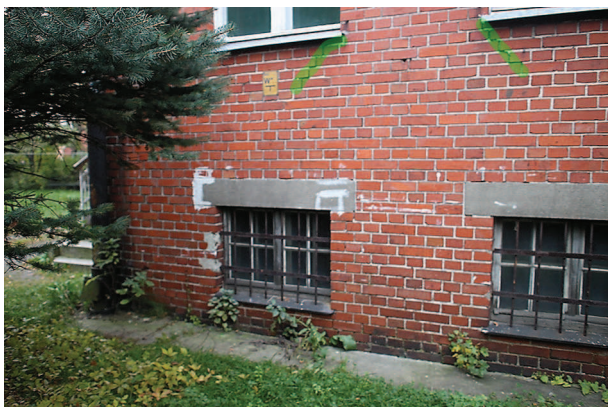
Rysy na ścianie północno-zachodniej
