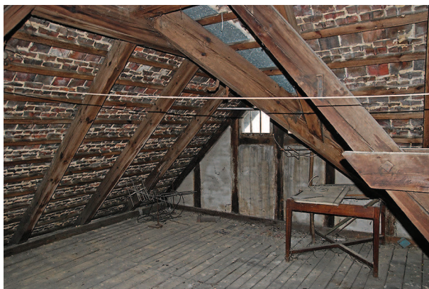
Zacieki na ścianie szczytowej pod oknem strychu
